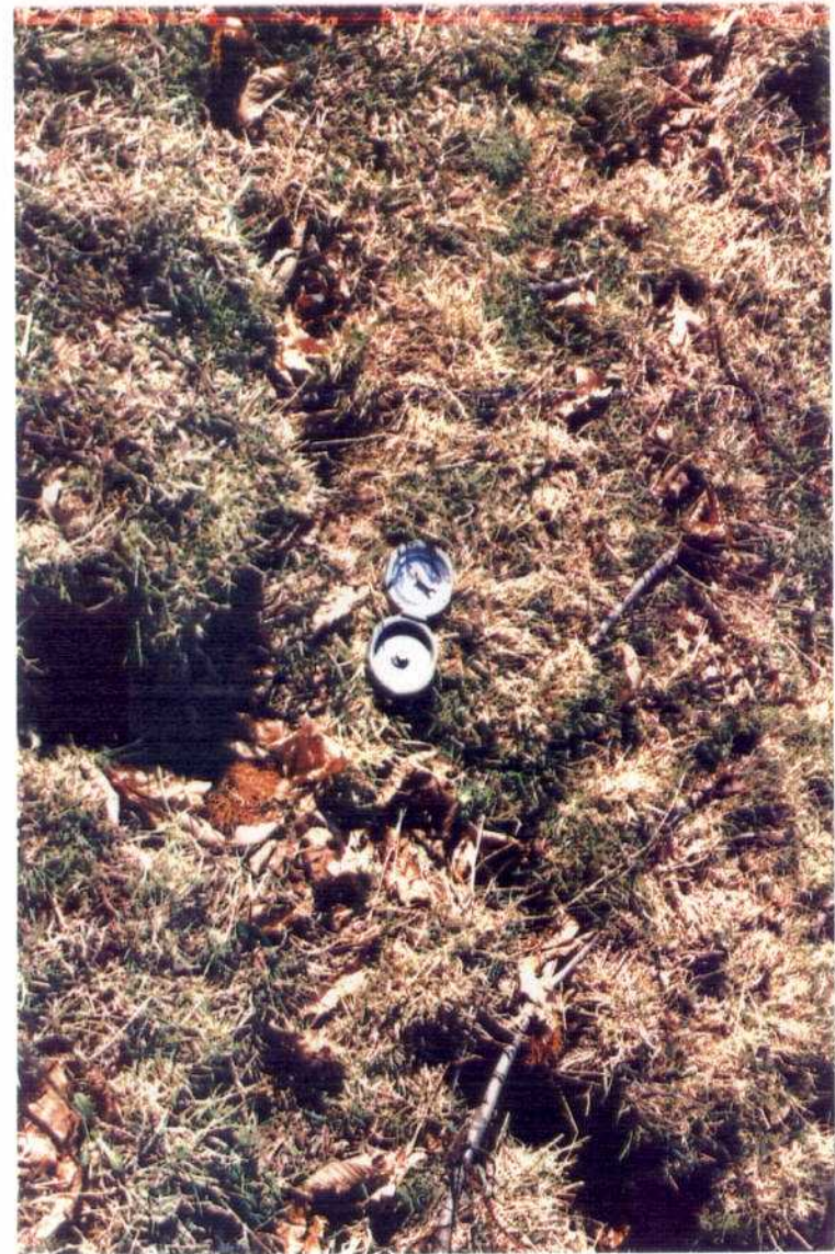
Fotografía nº 8: Grieta de tracción en el talud existente por encima de la carretera, justo encima del deslizamiento I.
